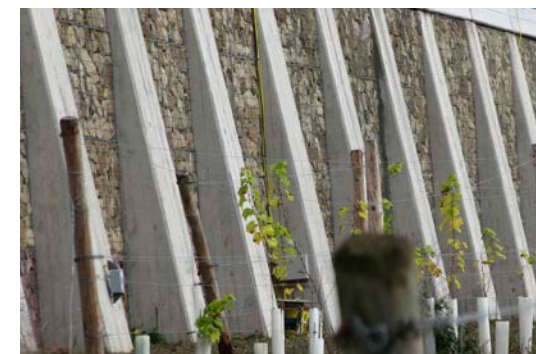
Stützwände mit Pfeilern sichern zukünftig den Bahndamm.
